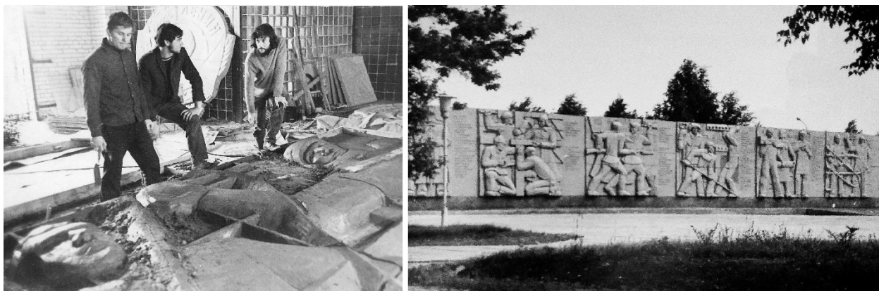
Іл. 1. Зліва – колективне виконання рельєфу з бетону. Справа – готовий та встановлений рельєф 1 . Розмір: висота – 6 м, довжина – 50 м. 1972 р. (Приватний архів П. Фелдеші).
