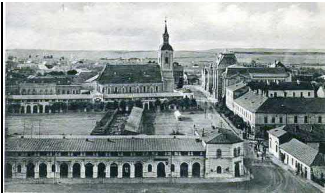
Рис. 3. Ринкова площа та реформатська церква в Берегові на початку XX ст. (ймовірне місце францисканського монастиря), [ https://karpatalja.ma/sorozatok/karpatalja-anno/karpatalja-anno-ilyen-volt-a-beregszaszi-hosok-tere/ (дата звернення 23.04.2021)].
