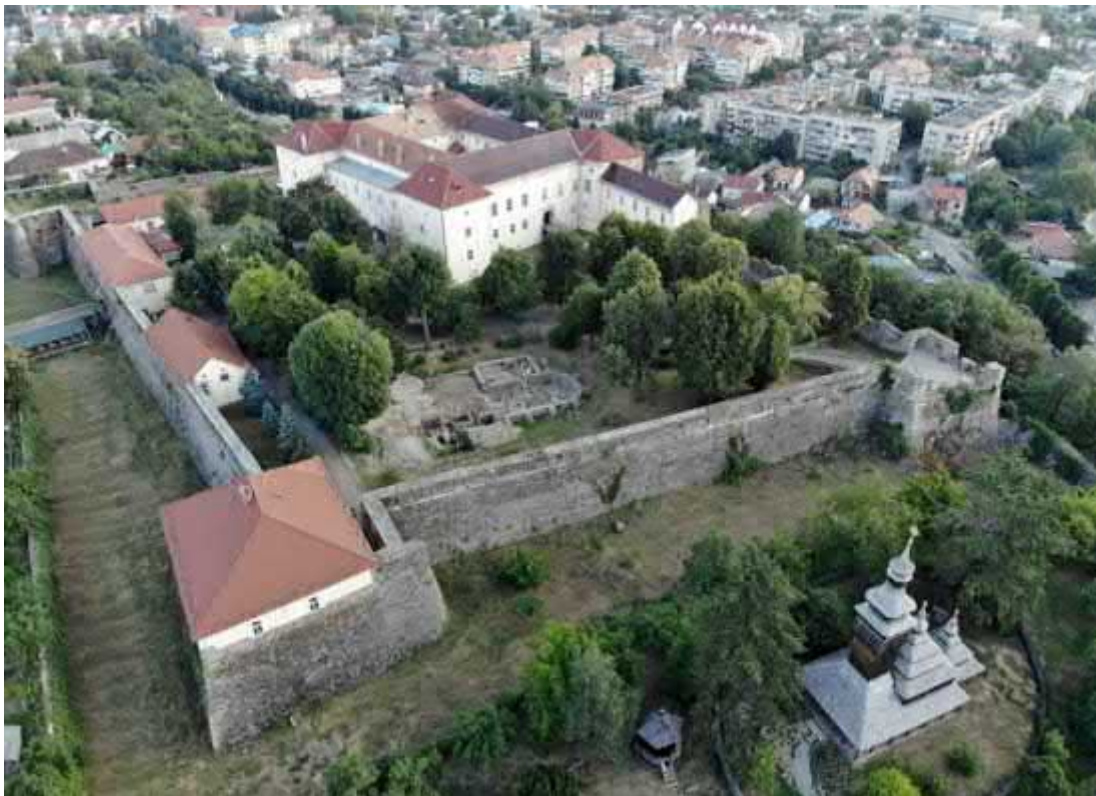
Рис. 1. Ужгородський замок (вигляд з півдня). Fig. 1. The castle of Uzhhorod (view from the south).
