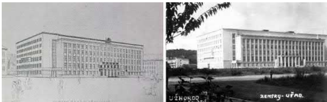
Рис. 8. Будівля Земського цивільного уряду Підкарпатської Русі. Ліворуч: ідейний ескіз будівлі, автор Ф. Крупка, Technická práce v zemi Podkarpatorské 1919 – 1933, p. 56. Праворуч: чільний південний фасад будівлі 1930-х рр., добова поштівка.
