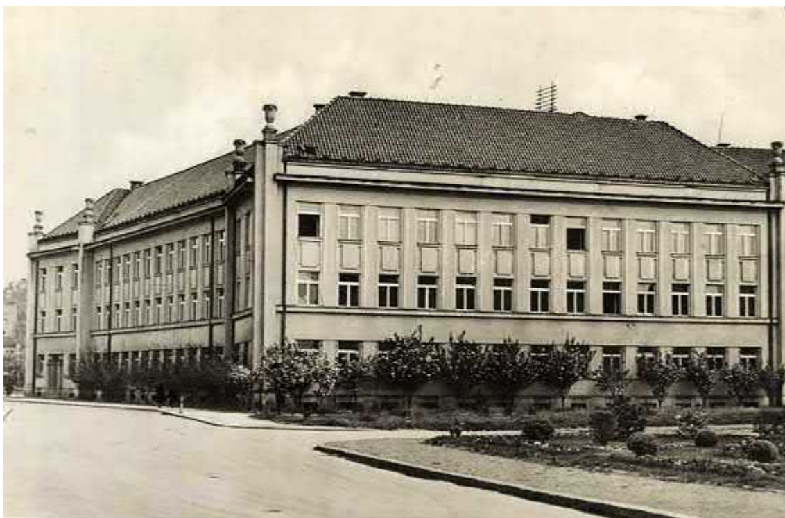
Рис. 2. Будівля поліцейного управління, південний і західний фасади, добова поштівка 1930-х рр.
